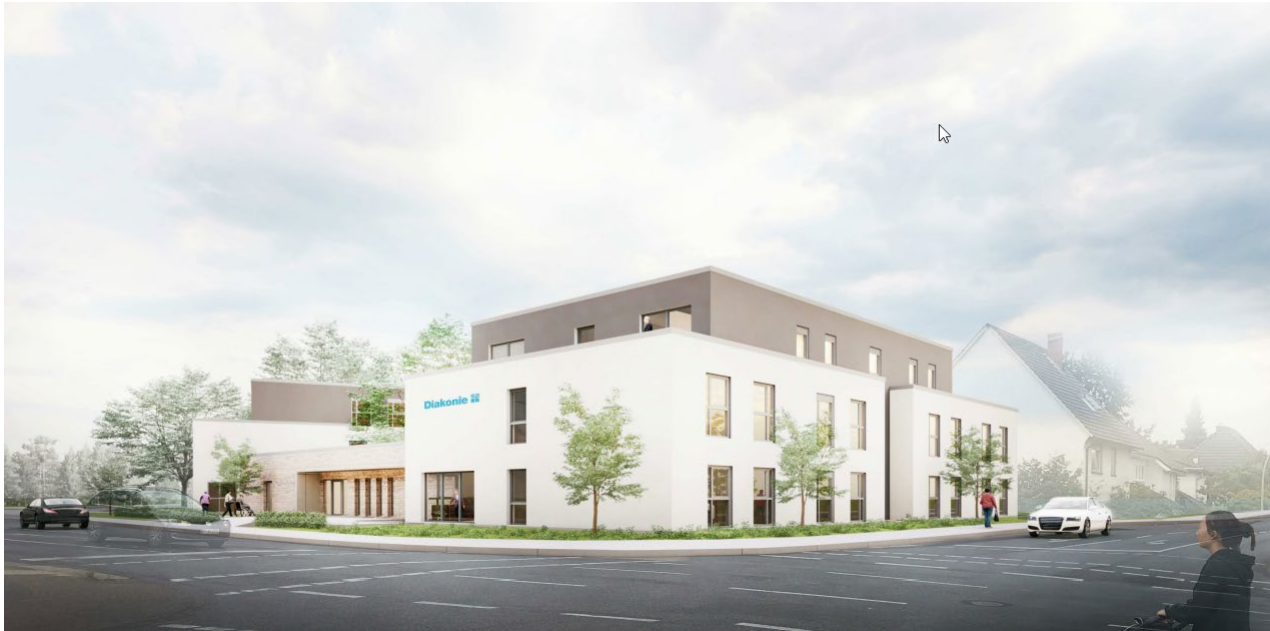
Ansicht Oelder Straße/Ringstraße
